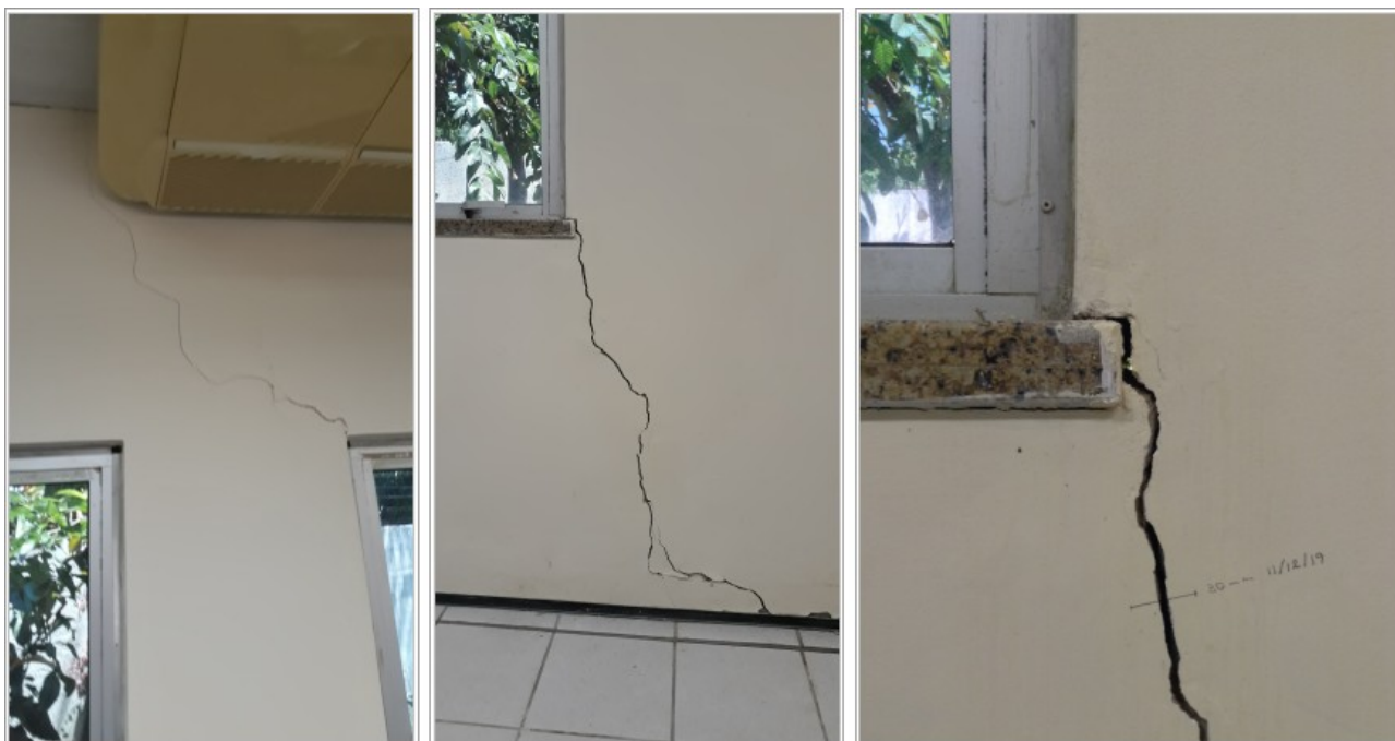
Foto 10: Parede leste, principais trincas e rachaduras
