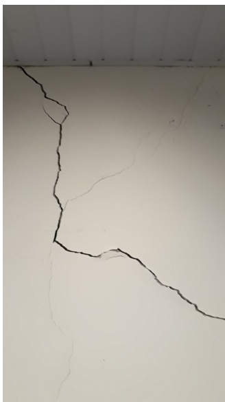
Foto 12: Parede sul, principal rachadura
