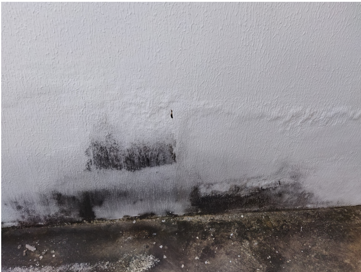
Foto 27: Infiltrações – quintal (umidade ascendente)
