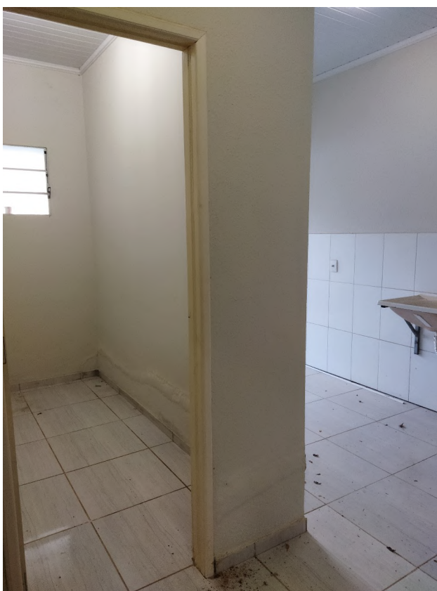
Foto 19: Despensa (umidade ascendente)
