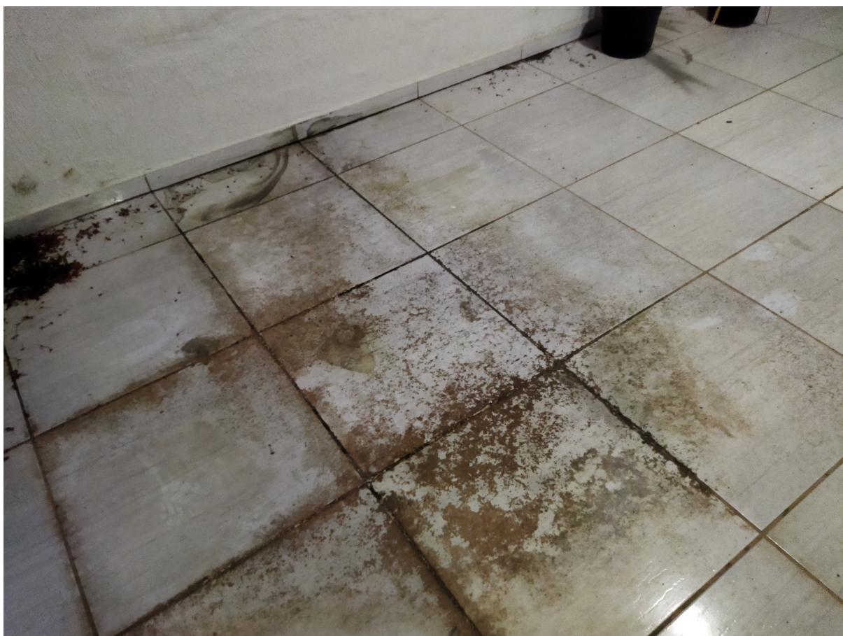
Foto 6: Piso com infiltração (terraço)
