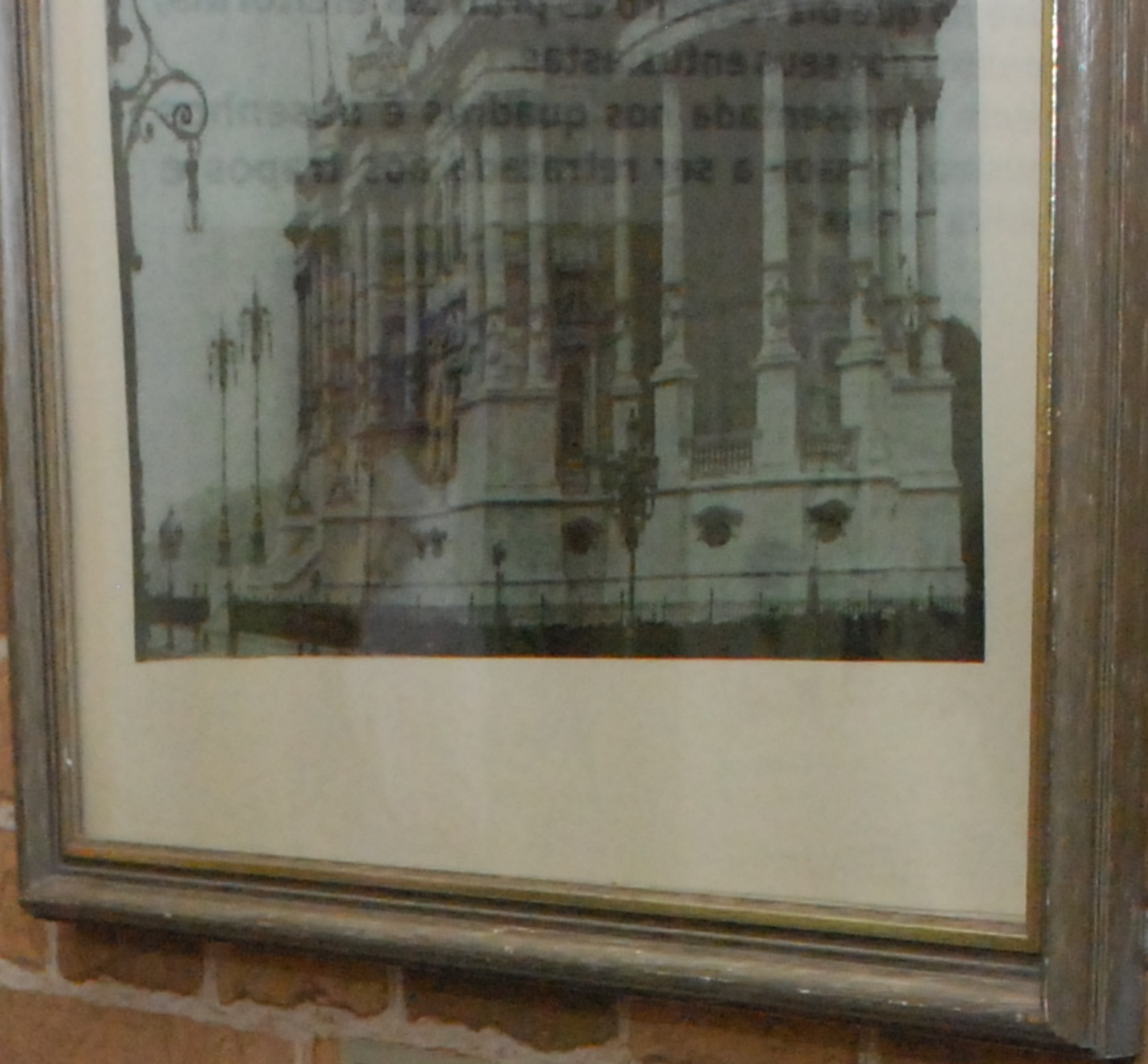
Fotografia do Palácio Monroe, onde funcionou o TSE
